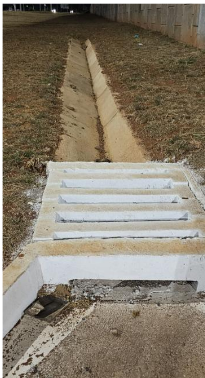
Figura 30 - Canaleta, bueiro e área permeável ao redor.
