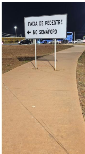
Figura 7 - Foto do passeio construído e inutilizado.
