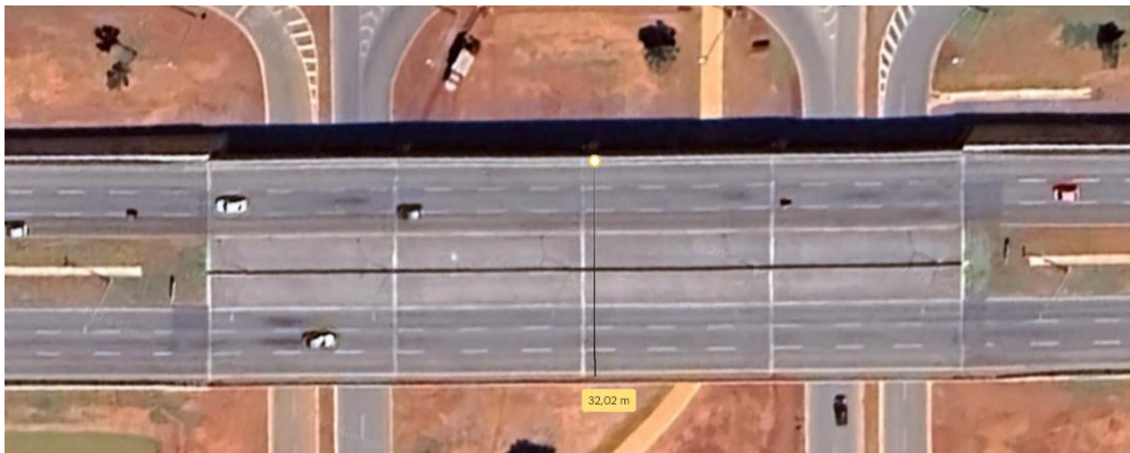
Figura 4 - Imagem aérea do viaduto extraída do Google Earth.
