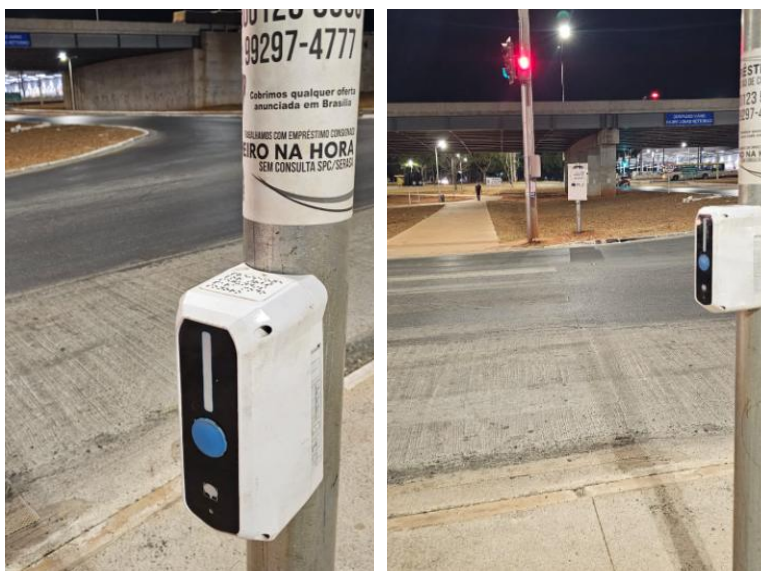
Figura 14 - Botoeira com instrução de uso em braille na parte superior do equipamento.
