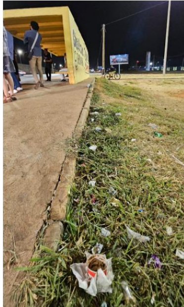
Figura 31 - Imagem demonstrando existência de lixos ao redor do abrigo.
