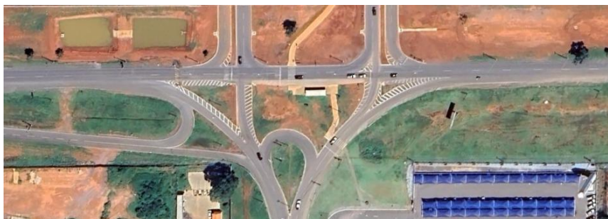
Figura 28 - Imagem aérea da interseção extraída do google maps.
