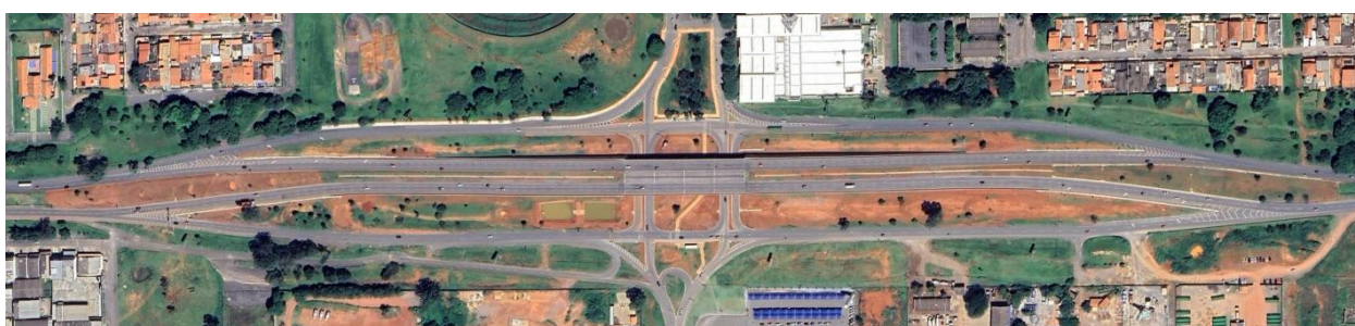
Figura 3 - Vista aérea do Complexo Viário Padre Jonas Vettorci. Fonte: Google Maps.
